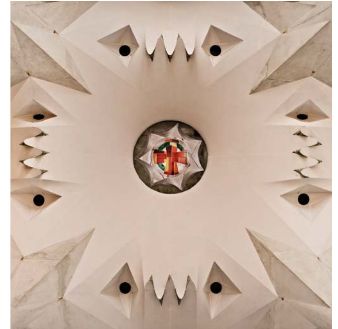
Voltes de la nau lateral, construïdes amb formigó blanc vist i amb encofrats de polièster i fibra de vidre.
