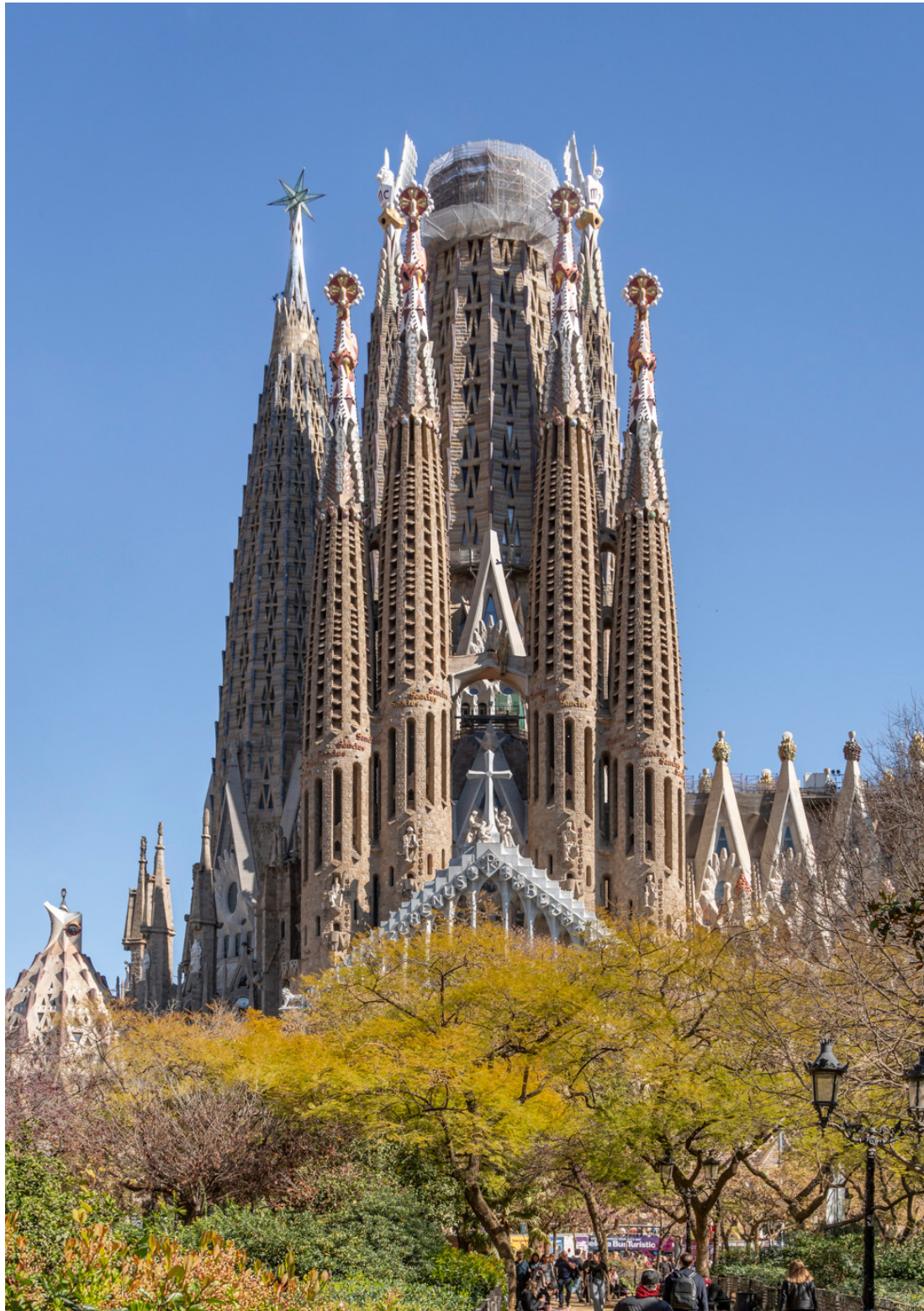
Vista de conjunt de la façana de la Passió.
