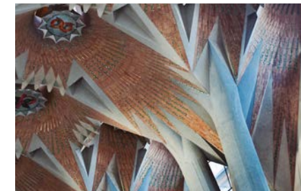
Tronco y ramas de un árbol y encuentro de una columna con una bóveda.
