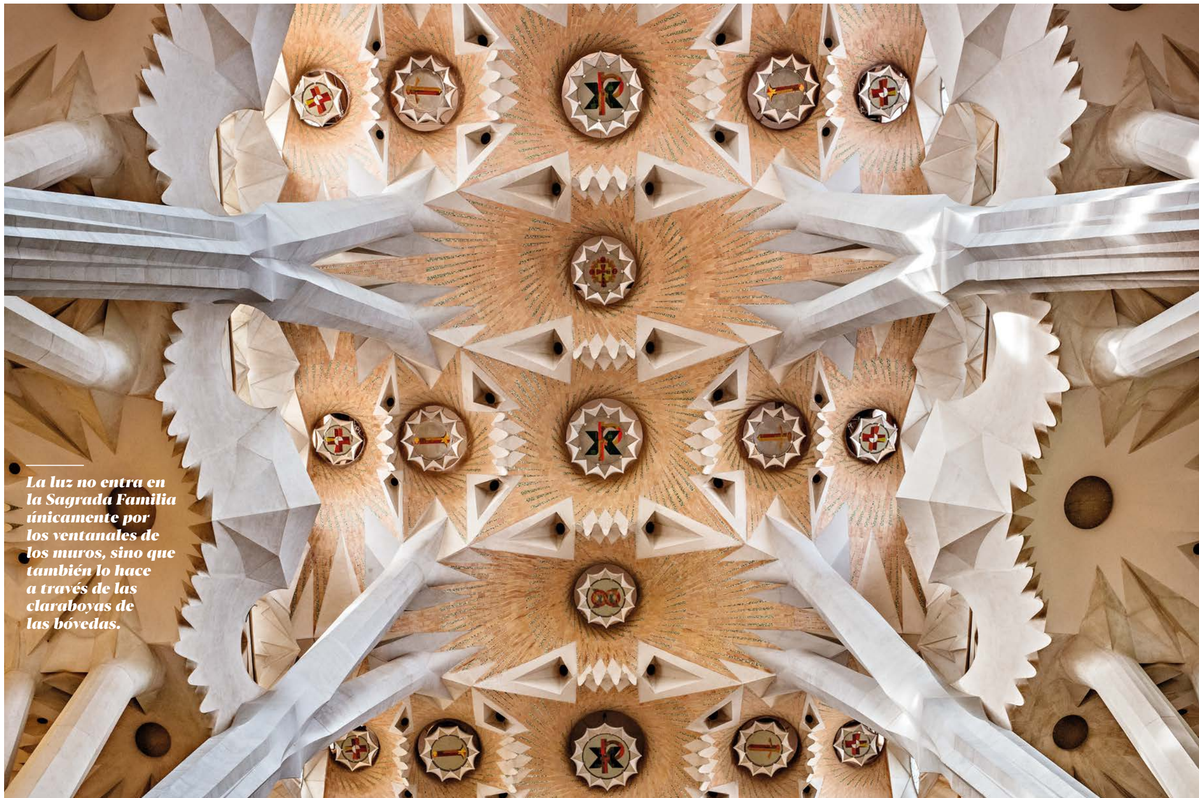
Lucernas o claraboyas de las bóvedas de la Basilica en forma de hiperboloide.
