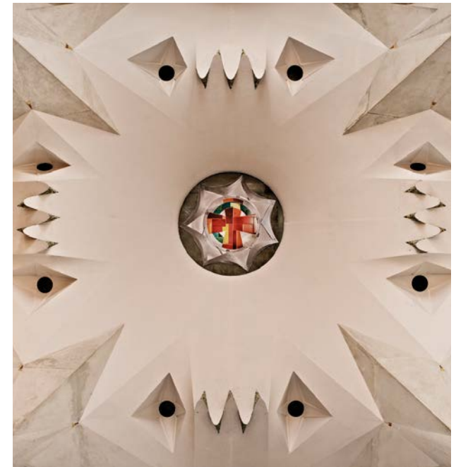
Bóvedas de la nave lateral, construidas con hormigón blanco visto y con encofrados de poliéster y fibra de vidrio.
