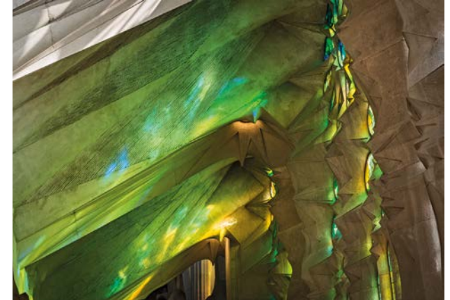
Bóvedas de la cantoría, construidas con prefabricados de hormigón y hormigón elaborado in situ .
