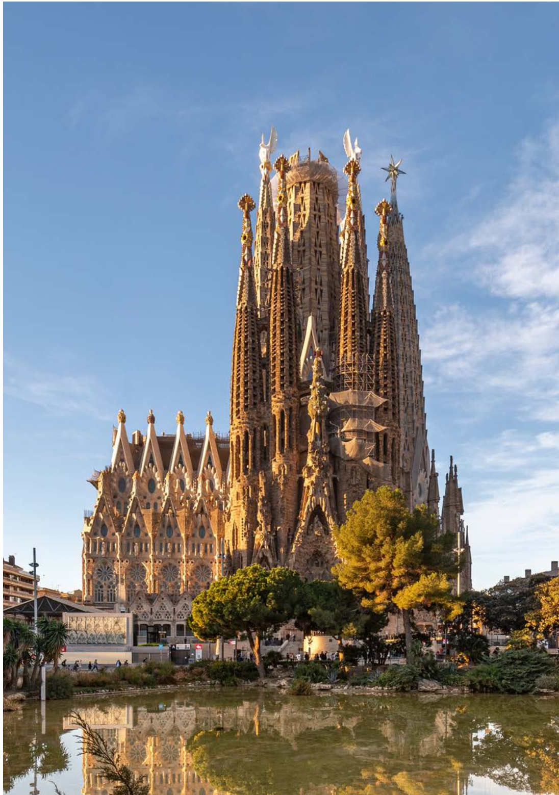
Vista de conjunto de la fachada del Nacimiento.
