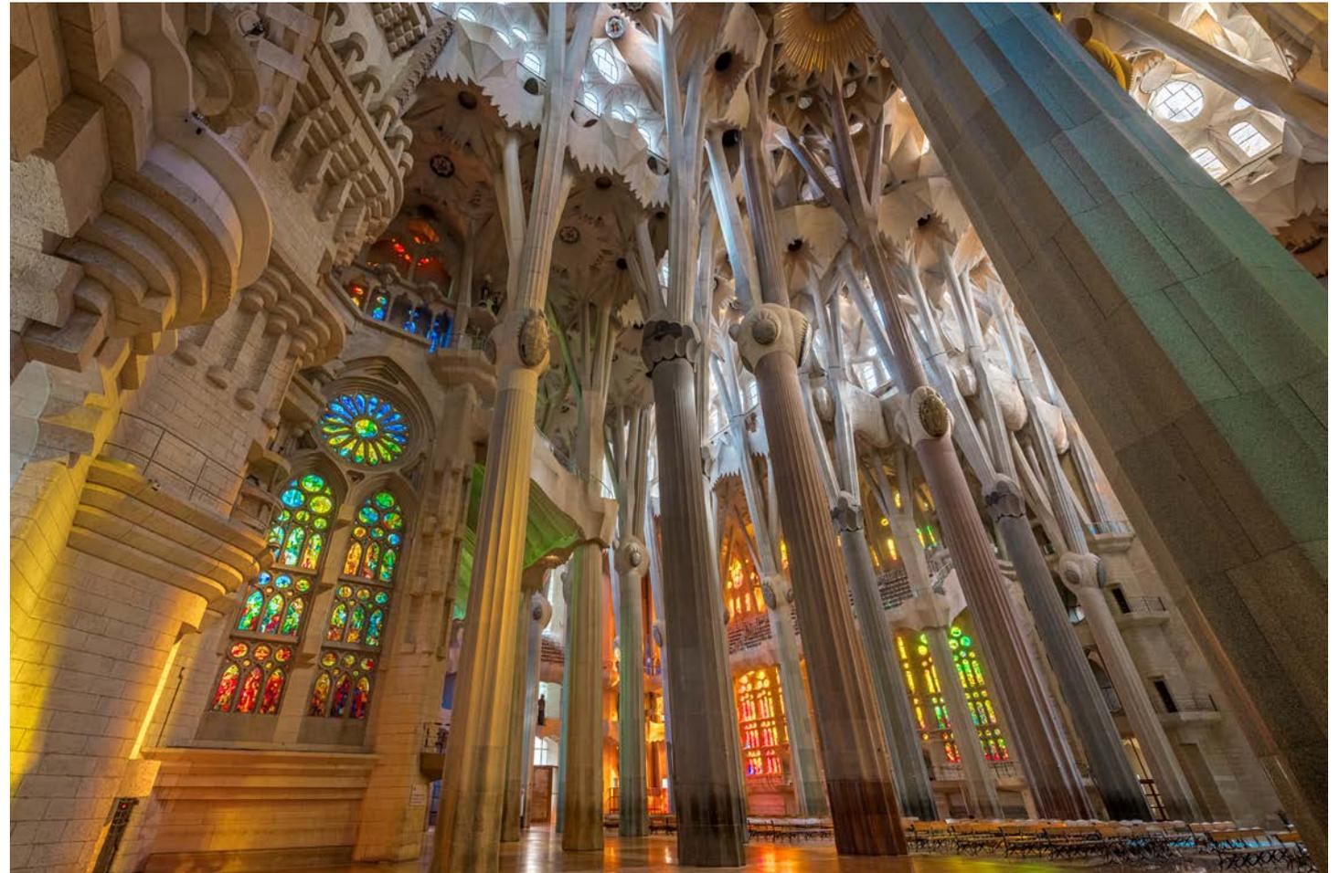
A partir del nudo, las columnas se desdoblán a diferentes alturas para soportar las bóvedas del templo (arriba).
