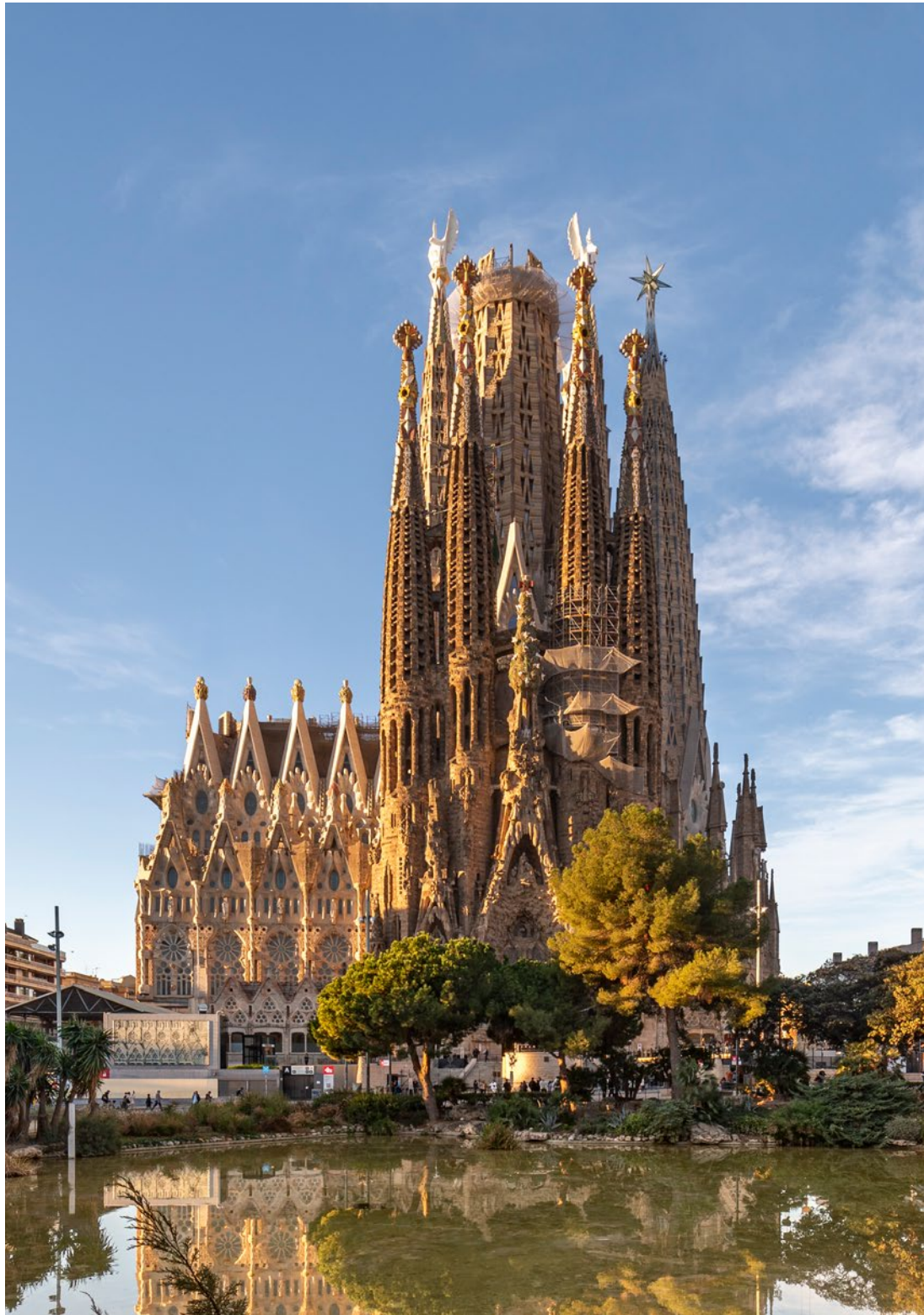
Vista de conjunt de la façana del Naixement.
