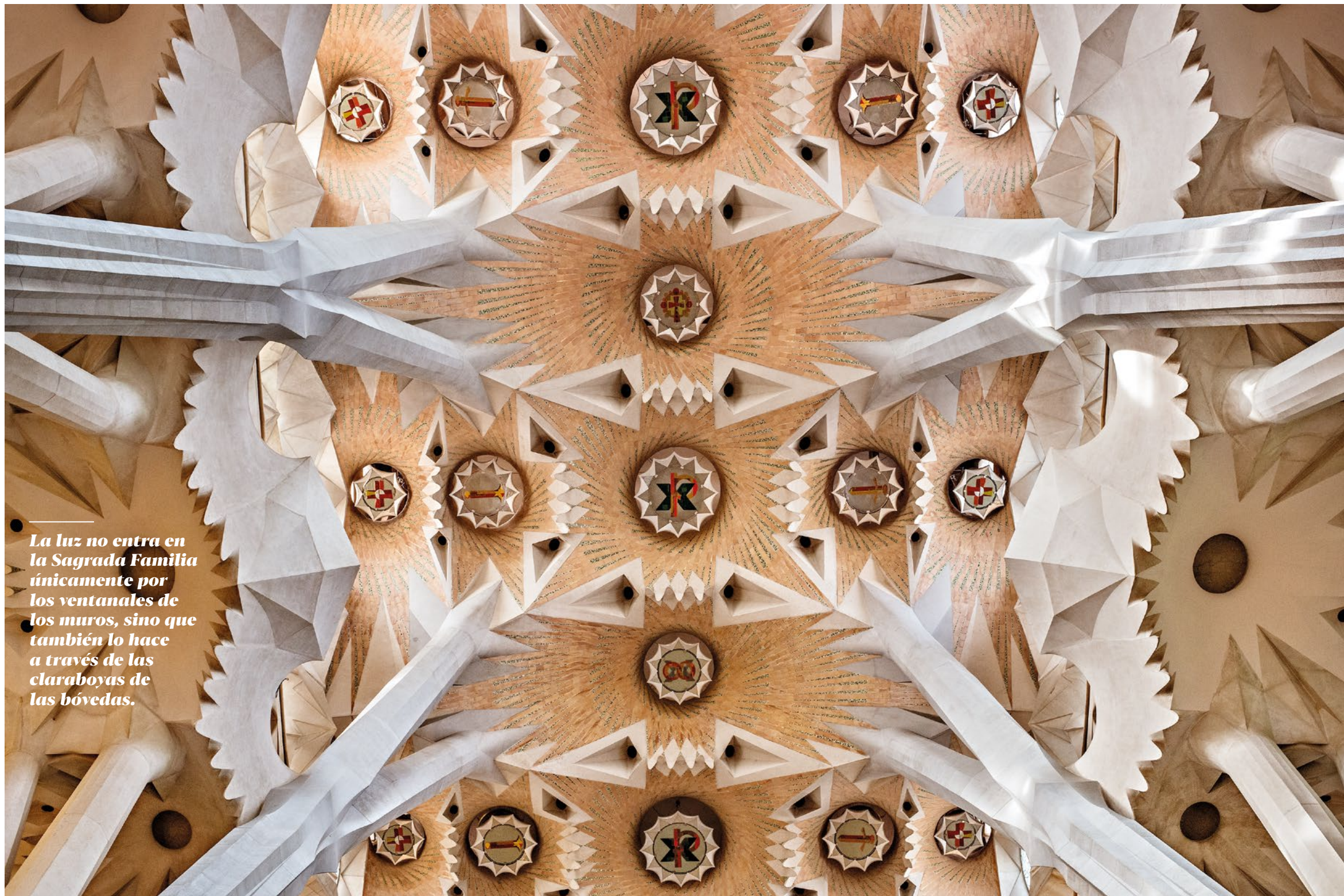
Lucernas o claraboyas de las bóvedas de la Basílica en forma de hiperboloide.
