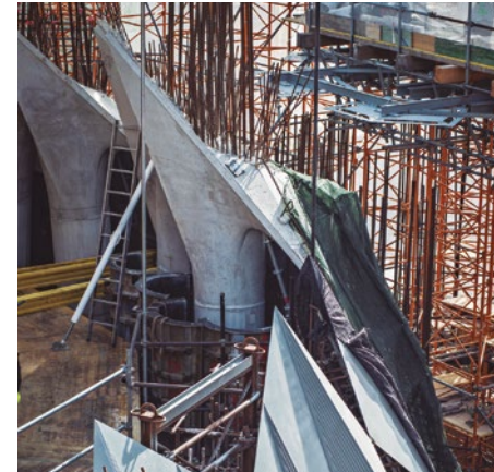
Columnas y capiteles de hormigón blanco de la Sala Crucero. Las columnas se han hormigonado in situ con moldes de poliéster, y los capiteles se han prefabricado con moldes de poliéster en el templo y se han elevado hasta el lugar correspondiente mediante la grúa.
