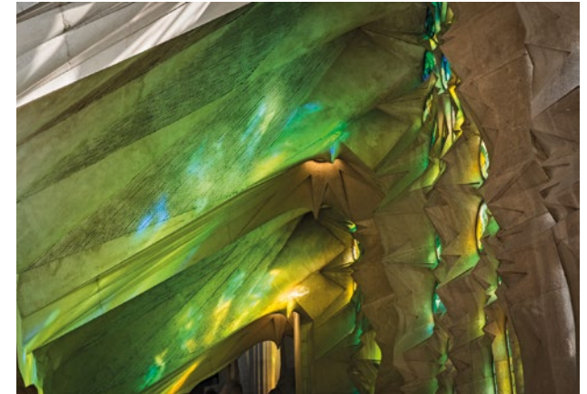
Bóvedas de la cantoría, construidas con prefabricados de hormigón y hormigón elaborado in situ .
