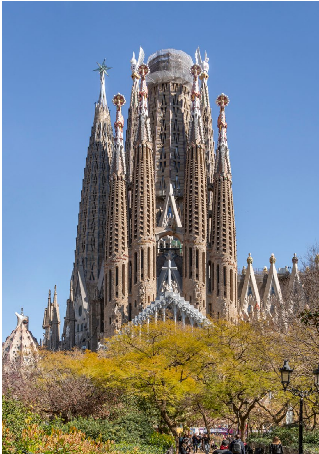
Vista de conjunto de la fachada de la Pasión.
